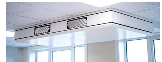
Mechanische Belüftung, Wärmerückgewinnung 80%, Einsparung von 130 Tonnen CO<sup>2</sup>
