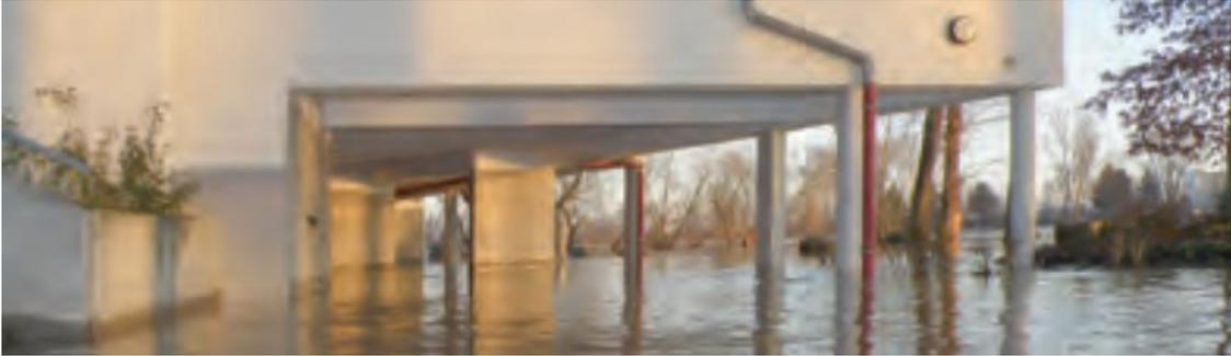
Abbildung 3: Aufgeständertes Gebäude (Hochwasserschutzfibel, Objektschutz und bauliche Vorsorge – BMUB (2016), Seite 24)
