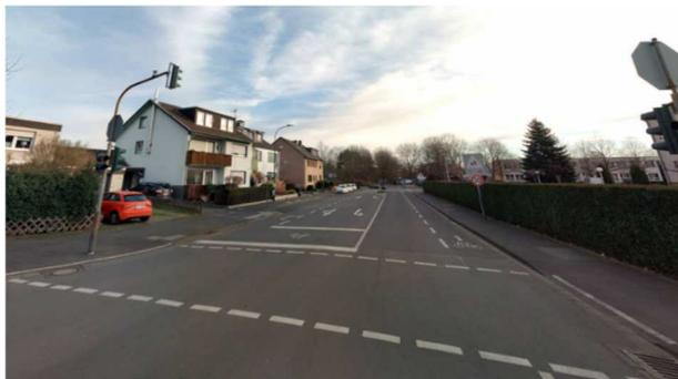
**Bild 138:** Matthias-Langen-Straße – Schutzstreifenführung bei streckenbezogener Höchstgeschwindigkeit 30 km/h [Bildquelle: Stadt Troisdorf]
