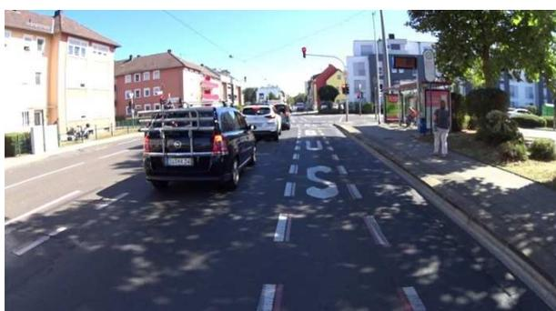
**Bild 152:** Frankfurter Straße (B 8) – Schutzstreifenmarkierung im Bereich einer Bushaltestelle
